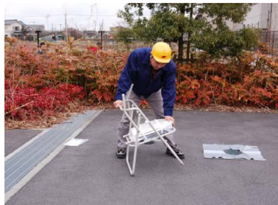
⑤ 便座が水平になるようにしっかり押し込みます
