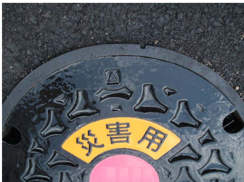
④ロックが外れました ふた上部の△と受枠の口がずれています
