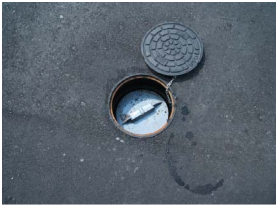
⑨ マンホールふたを開けます
