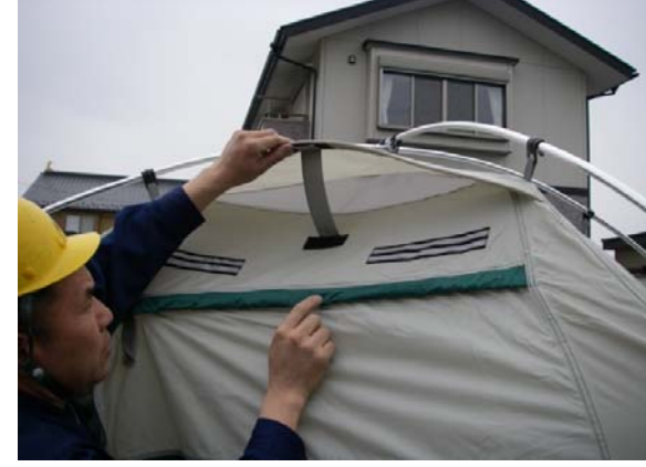
⑫ テント内部の換気を確保します
