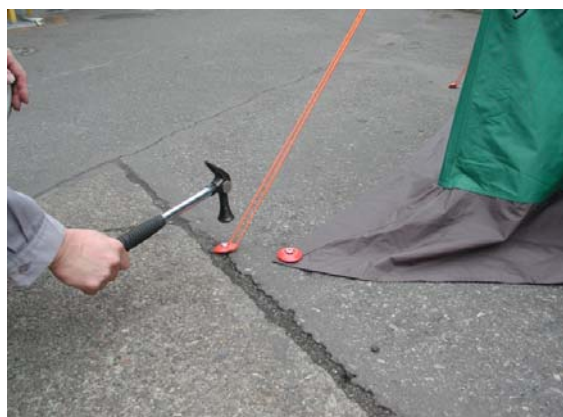
⑬ ハンマーで止め金具を打ち込み張り綱を固定します
