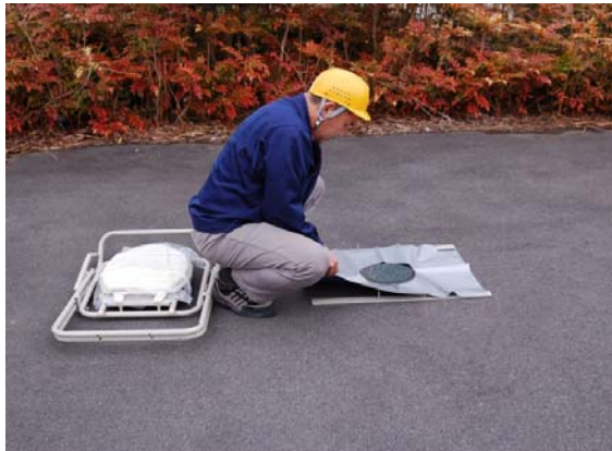
③ 安定金具にマンホールマスクをかぶせます
