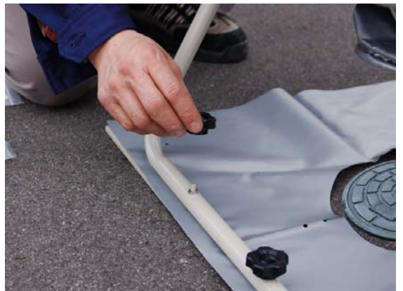
⑧ ワッシャ、ノブナットで4ヶ所のネジ部を締めます
