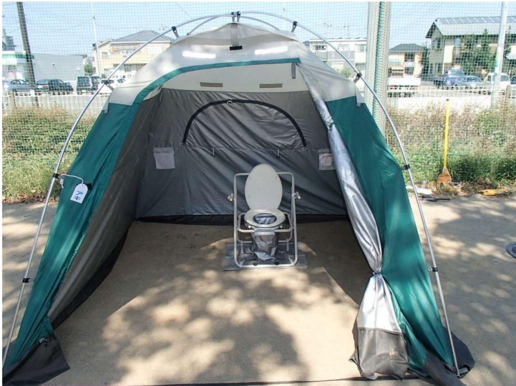
図8.2 災害用マンホールトイレ設置状況
