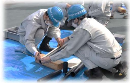
合同訓練は「**HIVP管を使用した応急給水栓の製作**」を作成しました。修得応急給水栓は、災害や事故などにより断水エリアが生じた際に、既設の消火栓等に設置することで応急的に給水活動を行う有効な手段となります。
