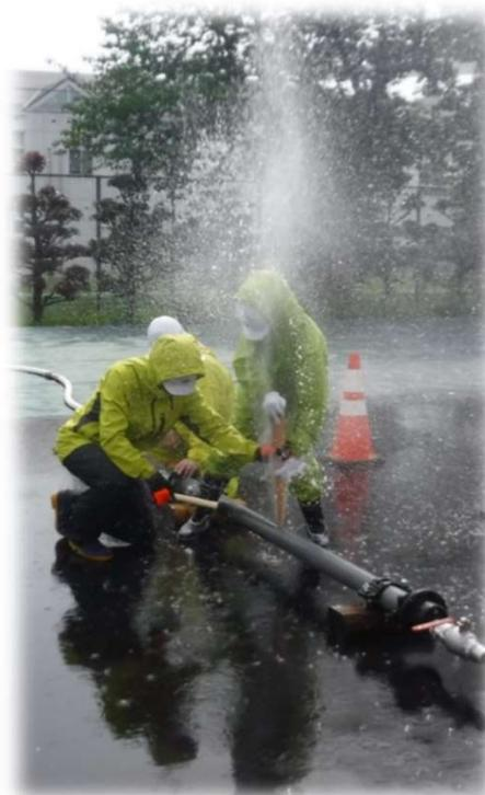
破損して漏水が発生している水道管に木栓(φ20mmに加工した木材)を直接打込み止水
