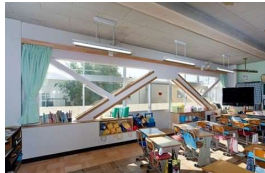
耐震補強後の教室の様子
