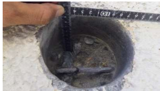
柱や梁のコンクリート内部の状況や建物の劣化等を確認する躯体の健全性調査
