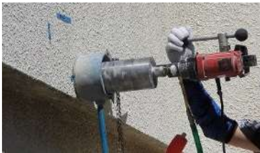
柱や梁のコンクリート内部の状況や建物の劣化等を確認する躯体の健全性調査
