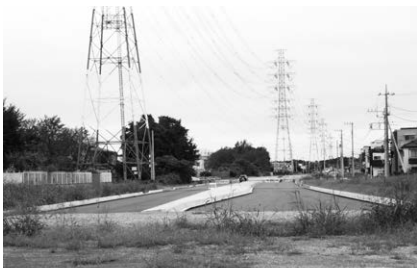
整備区間の起点付近(上尾環状線側)
