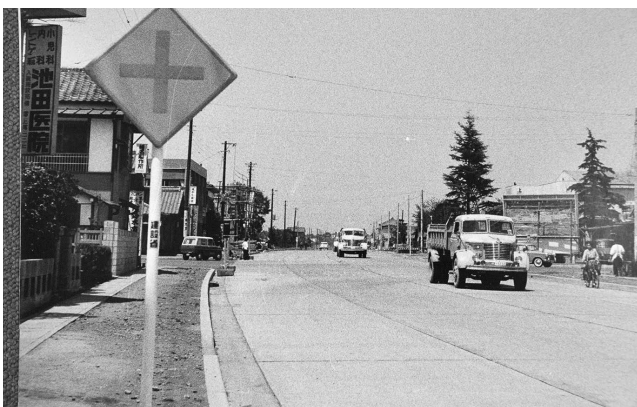
写真3 開通後の国道17号バイパス
