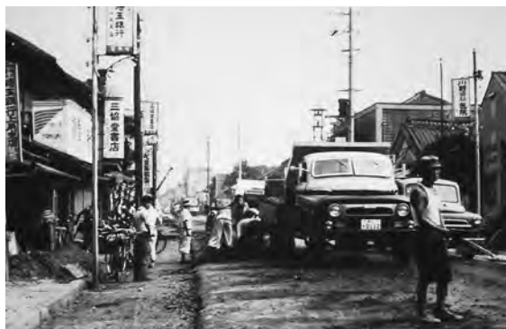
写真1 中山道の改修工事の様子(昭和32年8月)
