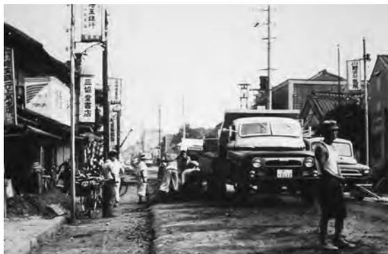
写真1 中山道の改修工事の様子(昭和32年8月)
