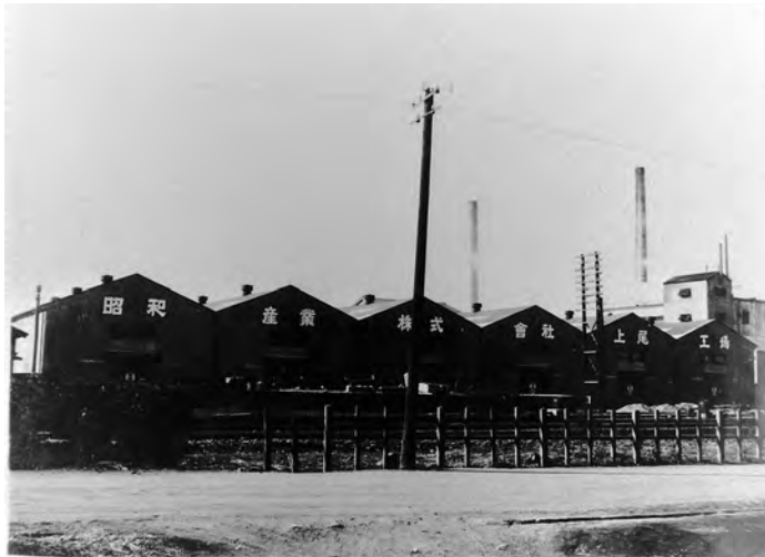
写真2 線路に沿って立ち並ぶ昭和産業株式会社 上尾工場
