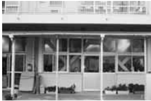
耐震補強済みの緑丘保育所
