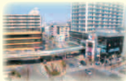
3月 JR上尾駅東口ペデストリアンデッキを延伸
