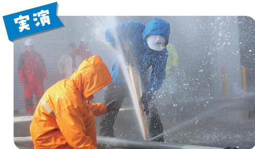
木材を使用した応急漏水修繕
