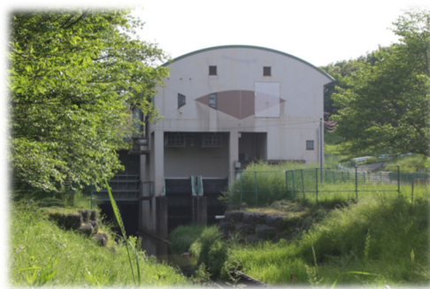
丸山ポンプ場
