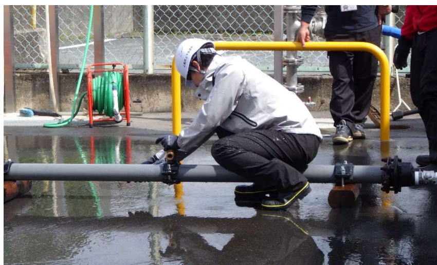
サドル付分水栓が固定されることによって漏水が止まりました。
