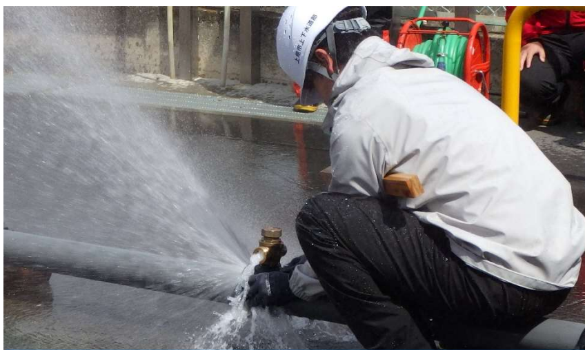
サドル付分水栓を漏水箇所に被せるように動かしていきます。
