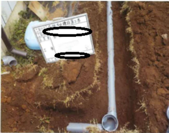
・配管布設のための掘削が完了した状況をどの配管かわかるように写すこと。
