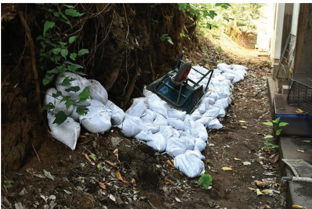
令和7年9月29日 土嚢袋による墳丘保護
