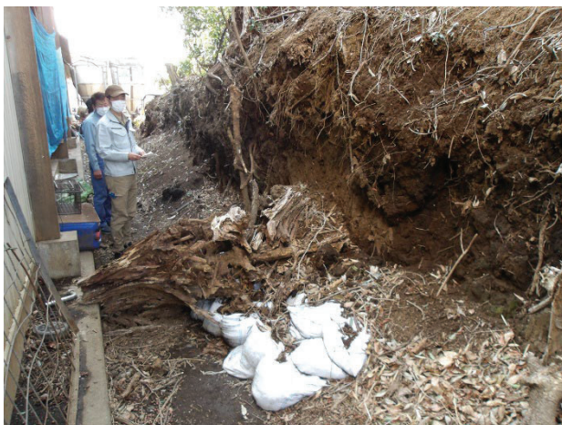
令和7年8月25日 樹木及び墳丘崩落
