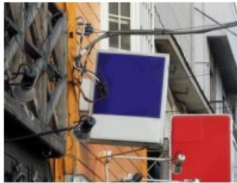
上部構造全体が傾斜した状態
