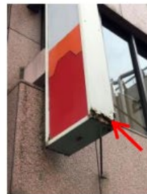
広告板底部の腐食が進行した状態
