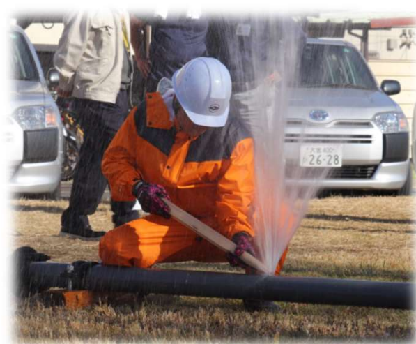
《木栓の先端を漏水箇所へセット》
