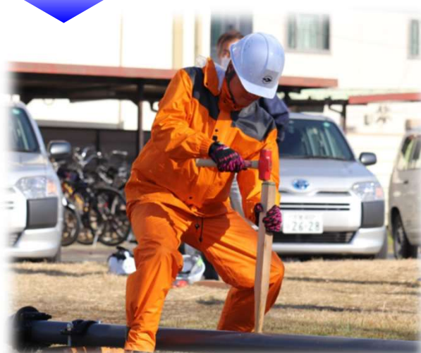
《セットハンマーにて木栓の打ち込み》 《上尾市上下水道部職員》
