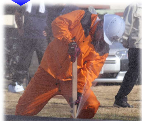
《体重を乗せて木栓の差し込み》
