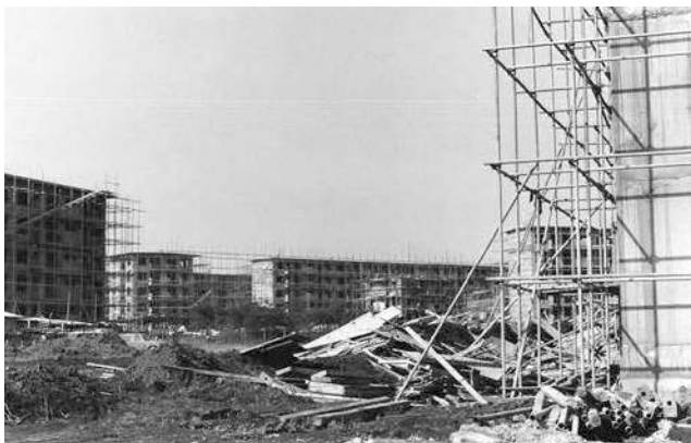
写真3 建設中の西上尾第一団地
