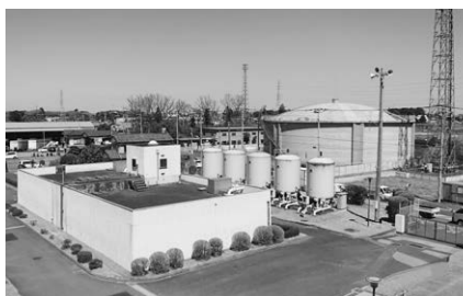
更新する着水井・混和池(手前の建物)
