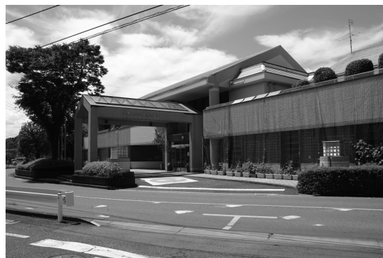
空調改修工事を行う上尾市総合福祉センター
