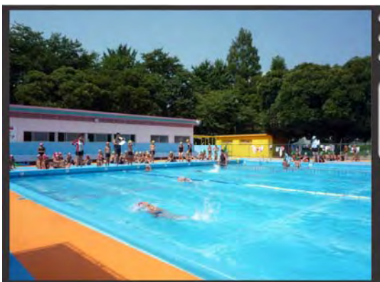
〔大石南小学校プール改修事業〕
