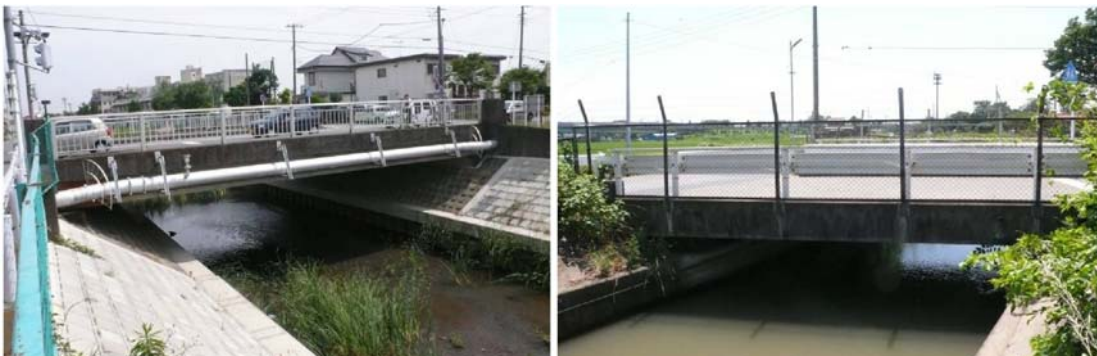
写真 3 河川,用水路を跨ぐ橋(左:鴨川を跨ぐ新弁財橋、右:見沼用水を跨ぐ坂下橋)
