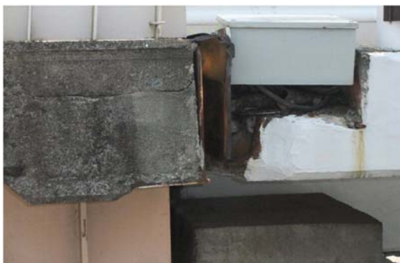
宏栄橋（1971年架設 橋長 156.4m）
