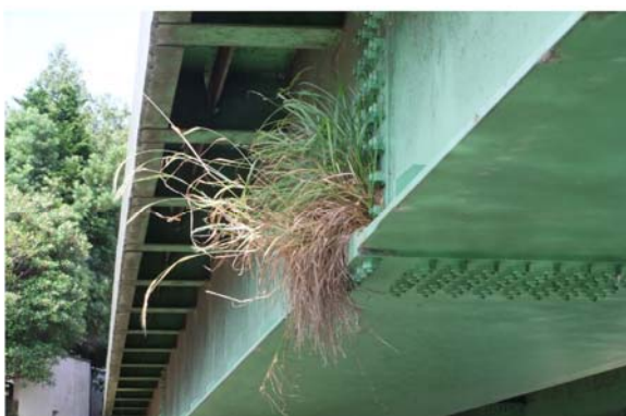
日の宮橋（1988年架設 橋長 44.8m）
