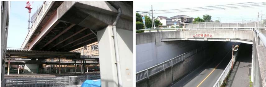
写真 2 跨線橋,跨道橋(左:JR を跨ぐ宏栄橋、右:市道を跨ぐ小敷谷吉田通線アソグ-西)
