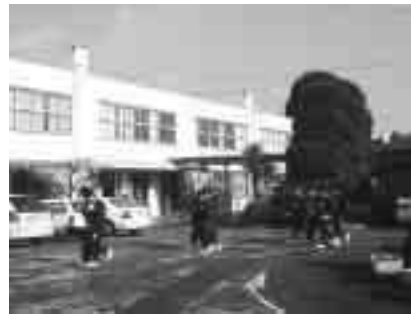
仮設校舎が必要な上尾中学校
