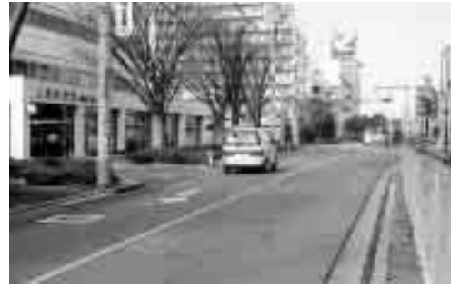
改良が望まれる上尾郵便局前道路
