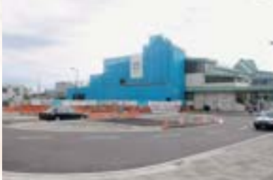
駅舎とロータリーの整備が進むJR北上尾駅
