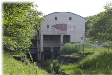
丸山ポンプ場
