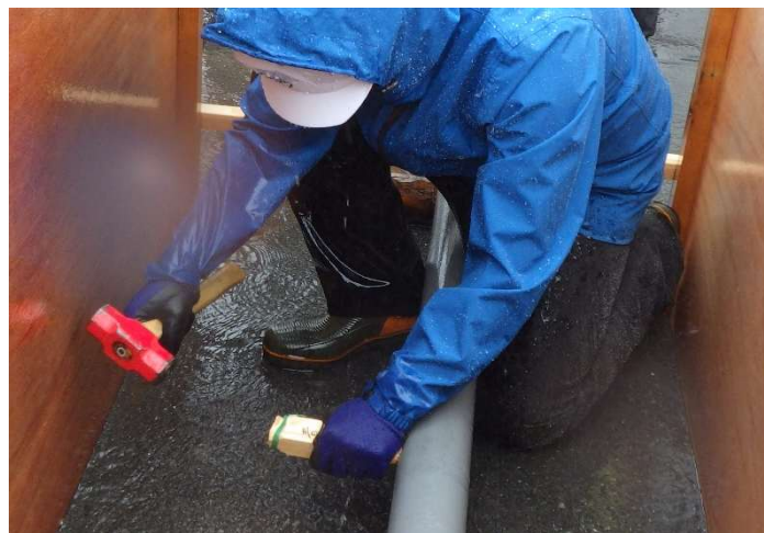
木栓の打ち込みにより止水されていく様子
