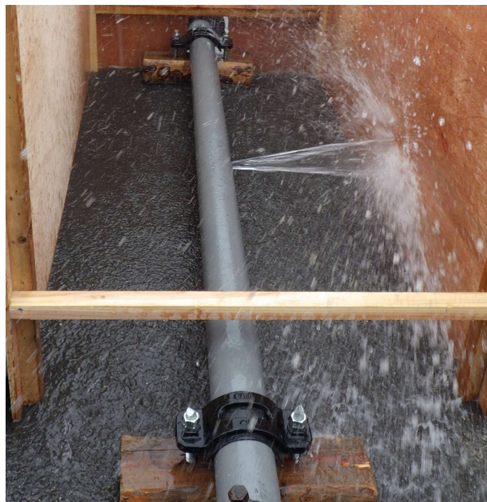
側面部からの漏水を想定した再現
