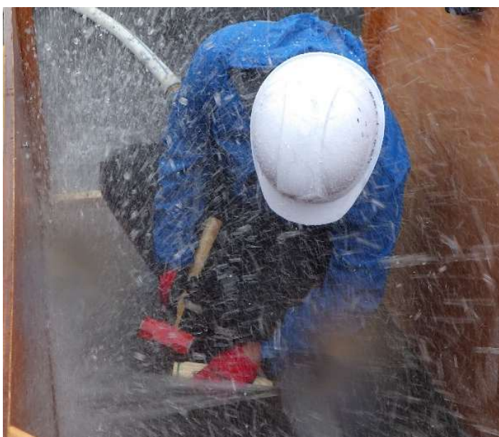
木栓を使用して打ち込みを実施
