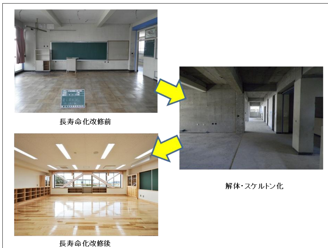
図表 3-12 長寿命化工事の例
