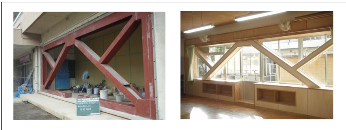
図表 3-10 耐震性向上の施工（公共建築物の例）
