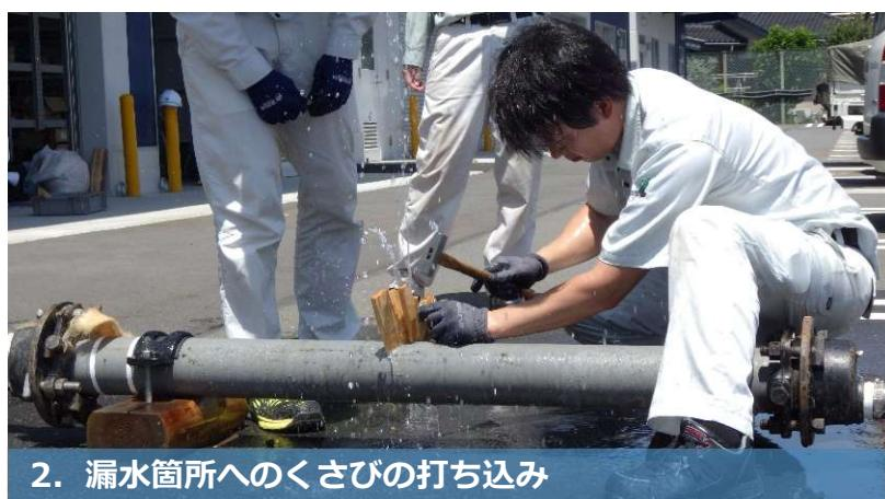
2. 漏水箇所へのくさびの打ち込み
