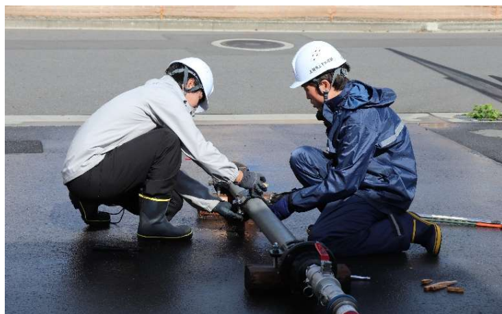
2. サドル付き分水栓の取り付け
