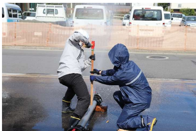
1. ハンマーによる木栓の打ち込み
