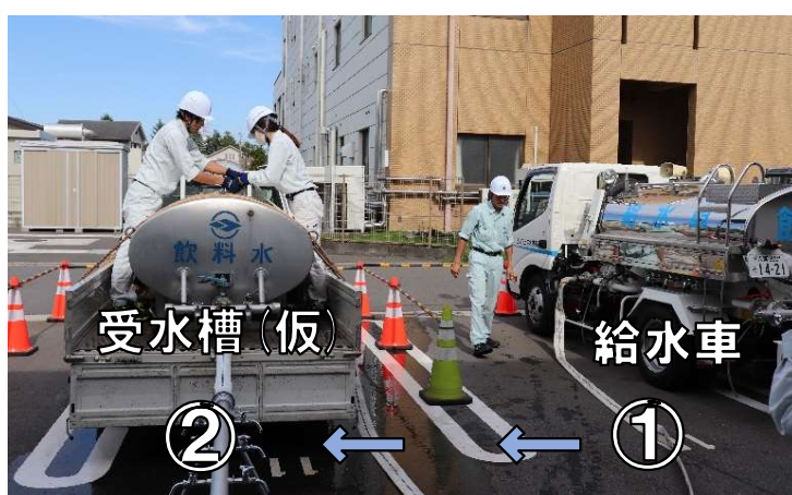
4. 給水車から可搬式応急給水タンクへの圧送
