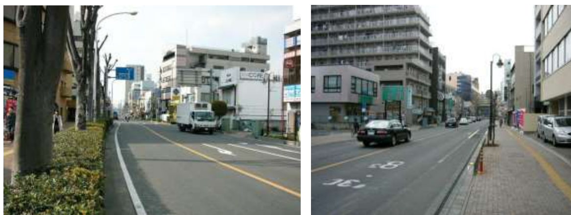
【上尾駅東口（旧中山道）の、電線類の地中化整備後の様子】
