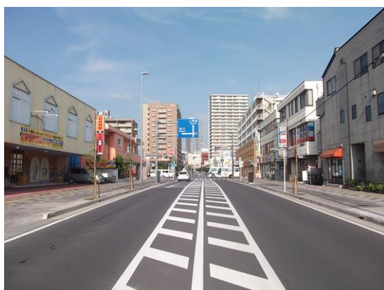
電線類地中化整備後の様子 左：上尾駅西口（上尾平方線） 右：上尾駅東口（旧中山道）
