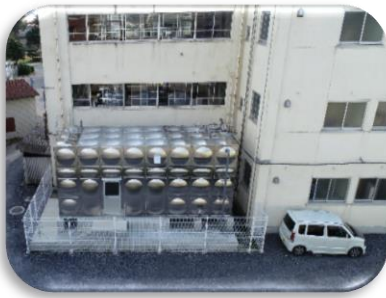
〔原市小学校受水槽改修〕
